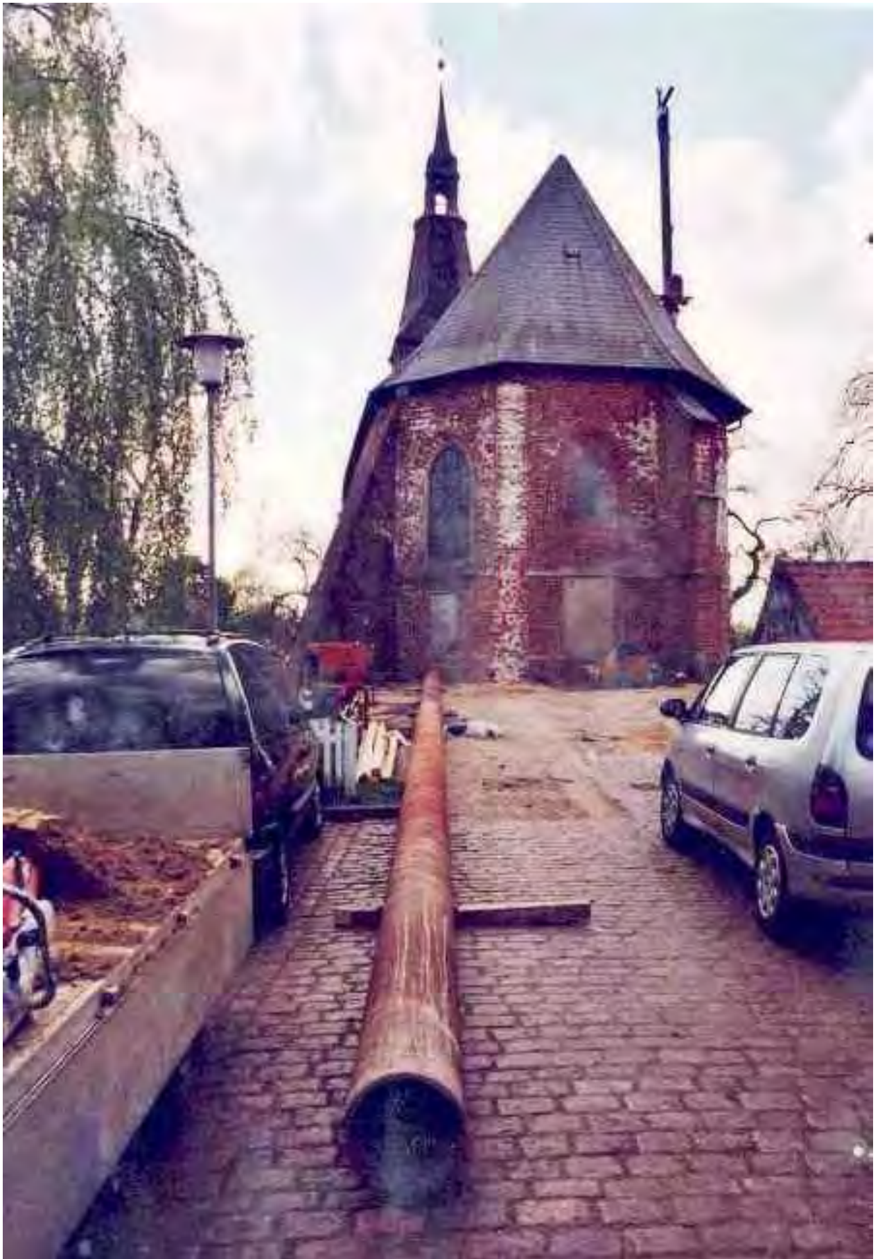
Das Bohrrohr für eine Tiefe bis 25 Meter.
