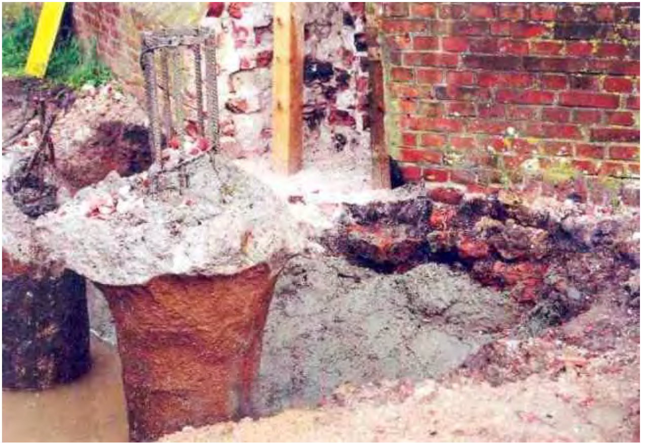
Oben: Die neuen Betonfundamente gehen 25 Meter in die Tiefe. Unten: Die neuen Betonstützpfiler werden geschüttet.
