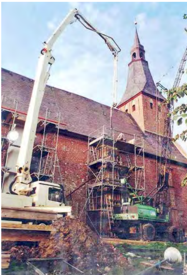
Oben: Die neuen Betonfundamente gehen 25 Meter in die Tiefe. Unten: Die neuen Betonstützpfiler werden geschüttet.
